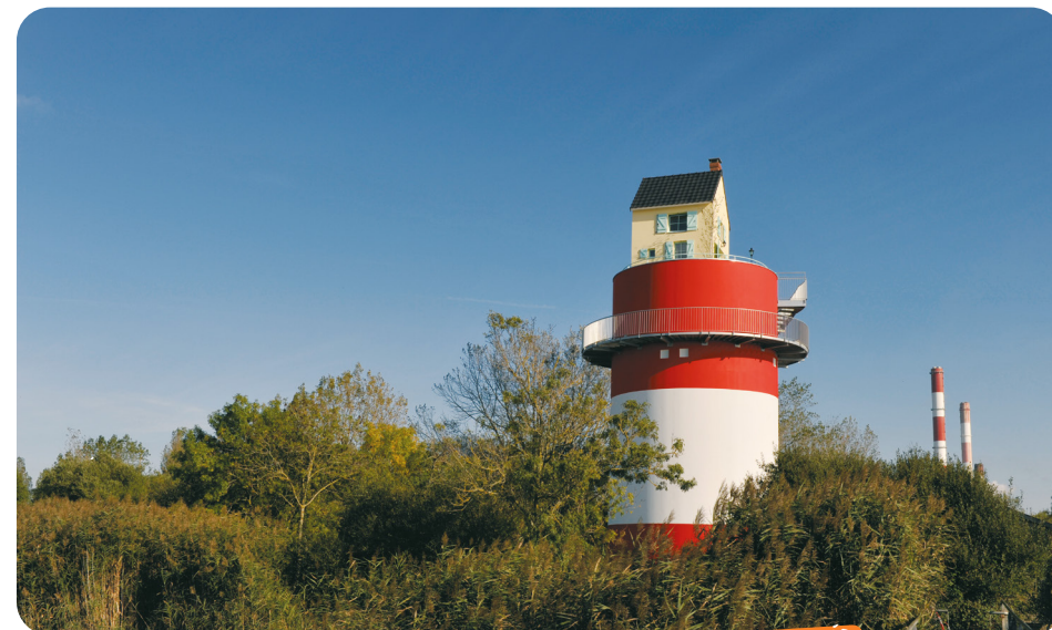
VILLA CHEMINÉE CORDEMAIS
