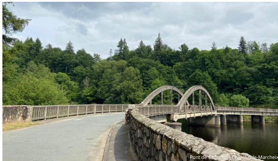
Pont de Châtelus - Châtelus-le-Marcheix
